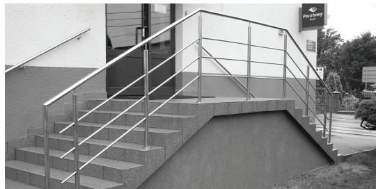
W budynku Urzędu Gminy w Mierzęcicach wykonano nowe schody zewnętrzne przy głównym wejściu do budynku.
