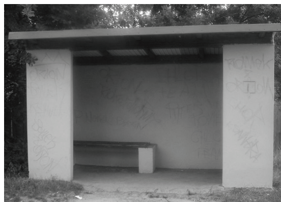
Przystanek przy ul. 21 Stycznia w Przeczycach - tydzień po malowaniu.
