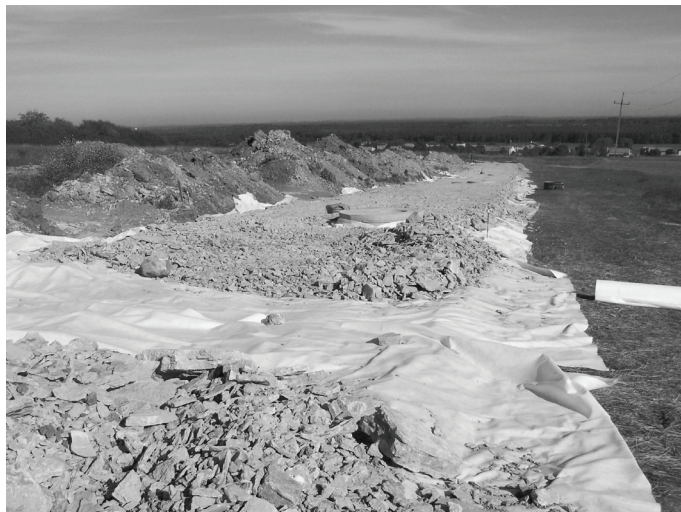
W listopadzie ogłoszono nowy przetarg na dokończenie budowy ul. Zjazdowej w Sadowiu.
