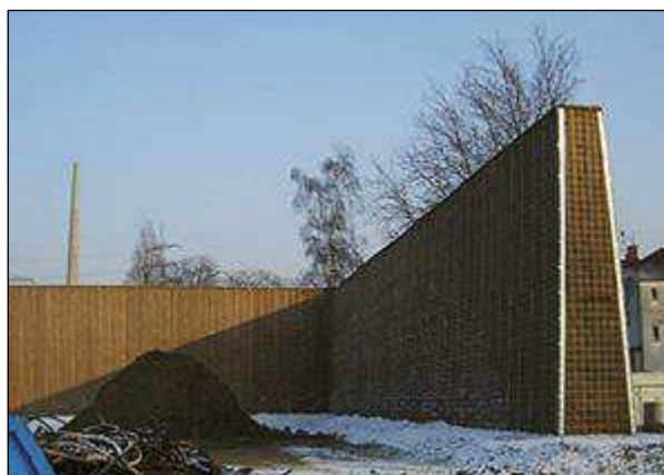
Rysunek 4. Przykładowy ekran akustyczny – ziemny ekran akustyczny z konstrukcją stalową. [Źródło: Ecotec Polska]
