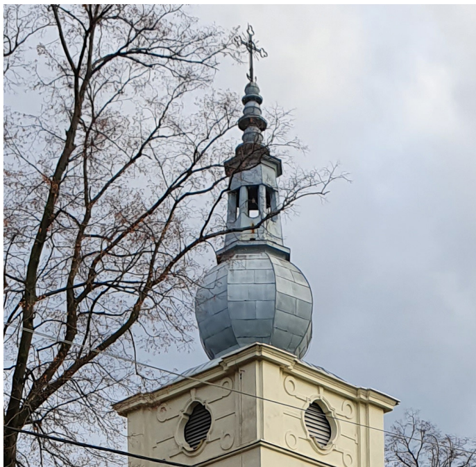
Wieża Kościoła Parafialnego Św. Mikołaja w Targoszycach - przed remontem
