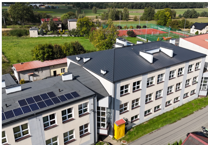
Pokrycie dachowe na budynku SP nr 1 w Mierzęcicach - po
