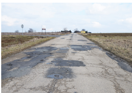
Ulica Nowowiejska w Zawadzie - przed
