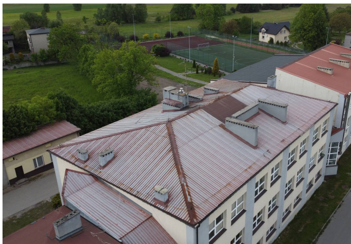
Pokrycie dachowe na budynku SP nr 1 w Mierzęcicach - przed
