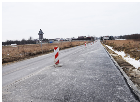
Ulica Gminna w Mierzęcicach - w trakcie
