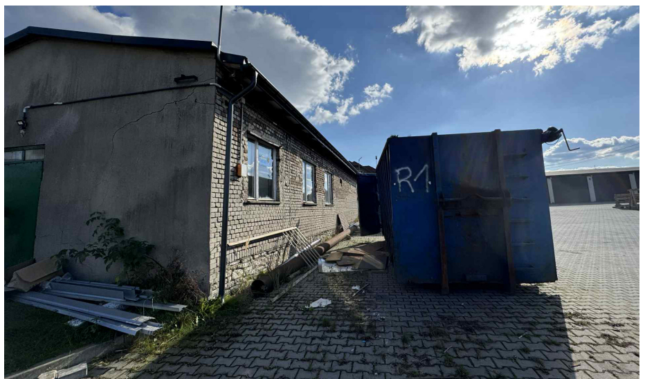
Zaplecze magazynowe na terenie GZGWik - przed
