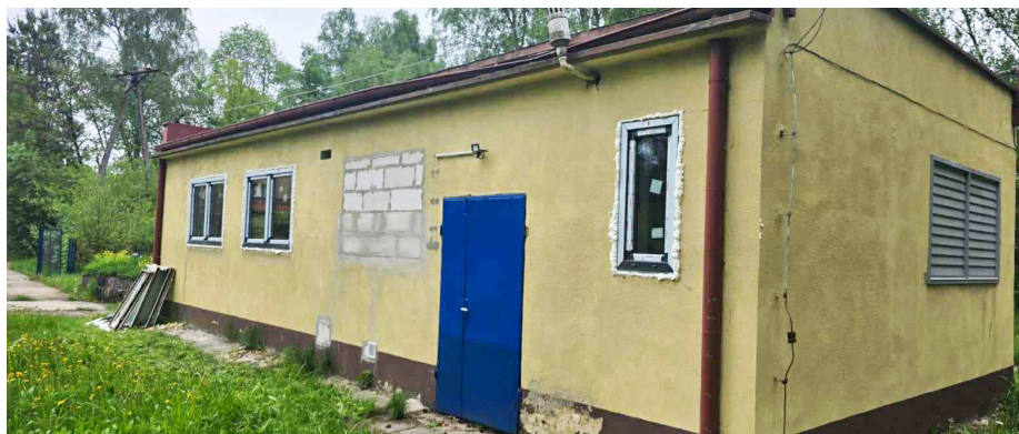
Ujęcie Wody w Przeczycach przy ulicy Targowej - przed
